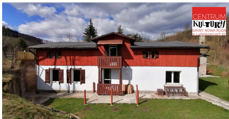
Muzeum „Przy Tunelu”, Świerki 101. Tuż obok tuneli kolejowych i stacji Świerki Dolne. Fot. Barbara Adamska.
