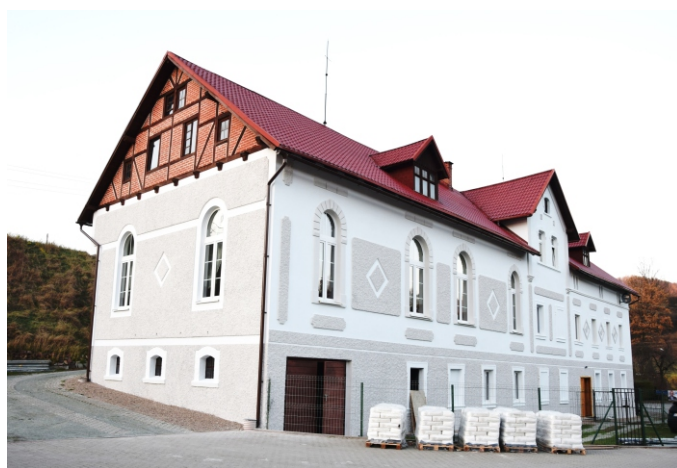
Fot. Budynek świetlicy i sali wiejskiej po termomodernizacji.
