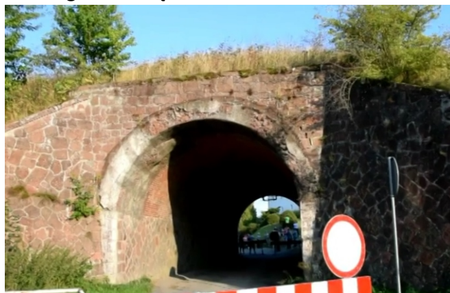
Fot. Wiadukt, który podzielił mieszkańców Dzikowca.
