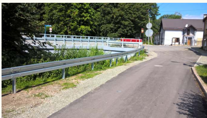
Fot. Nowe bariery przy drodze w Ludwikowicach Kł., niedaleko ronda.
