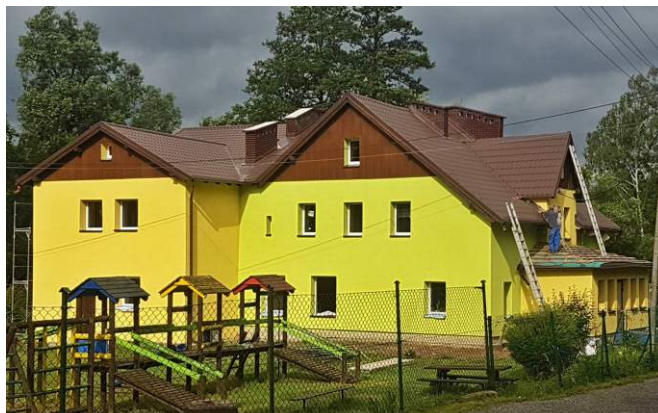
Fot. Zakończenie prac termomodernizacyjnych w przedszkolu w Woliborzu
