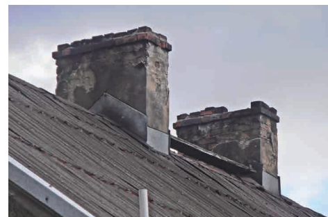
Włodowice nr 59 przed remontem
