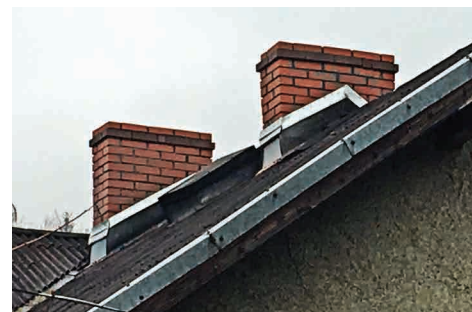
I po remoncie
