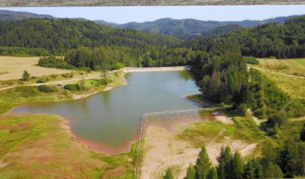
Remont tamy s. 5
