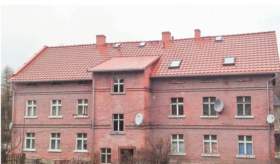
Gmina miała wkład w remont dachu budynku w Woliborzu nr 11 w wysokości 78,8%, przeznaczając na ten cel z budżetu kwotę 44.127,21 zł.
